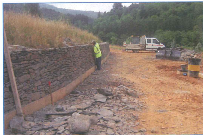
Mur en schiste à l'entrée du lotissement
