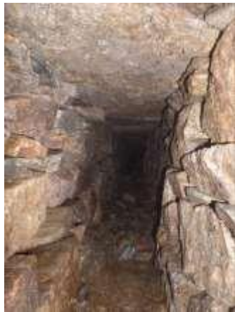
Dernière portion accessible =1m ; l=30cm environ
