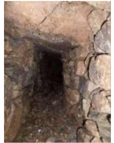
Murs en bon état, constitués de gros blocs de granit empilés sans liant couverts de larges dalles
